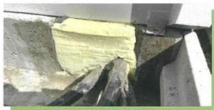
Mousse expansive organo-minérale pour obturer les entrées de câbles
