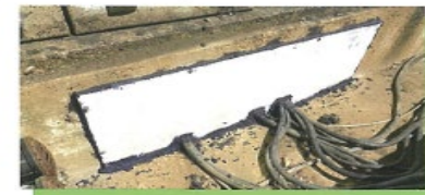
Panneau spécial en PVC blanc extrudé pour obturer les grandes ouvertures
